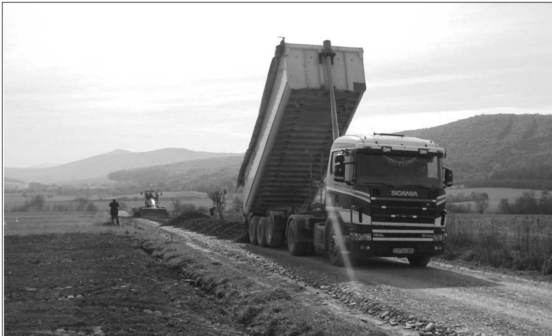
A MAGYARÓSI BEKÖTŐÚT ASZFALTJA ALÁ IDŐTÁLLÓ ALAPOZÁS KERÜLT
