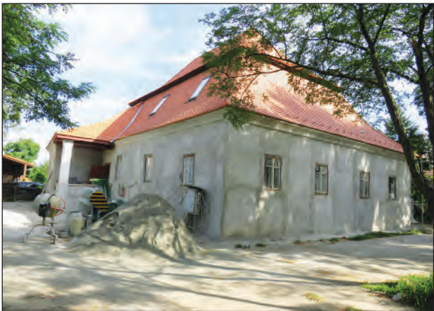
A Pünköszt-kúria felújítása
