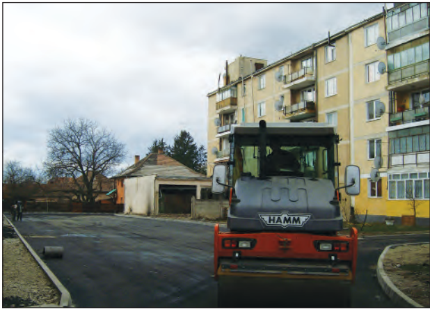
Tömbháznegyed korszerűsítése Uzonban
