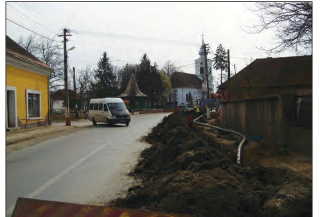
Ivóvízhálózat és szennyvízrendszer kiépítése
