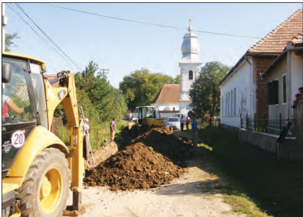
Szennyvízhálózat kiépítése Lisznyóban
