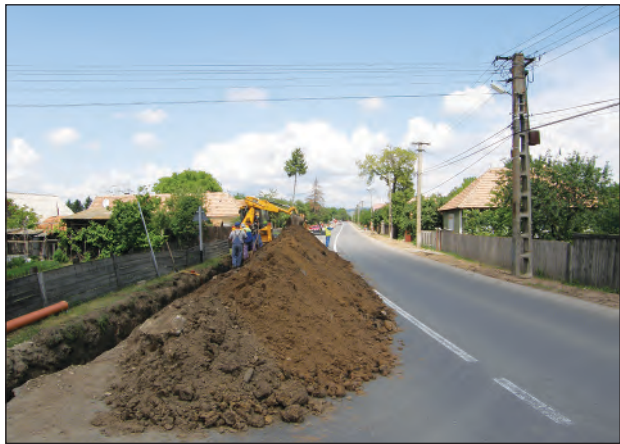
Szennyvízhálózat kiépítése Szentivánlaborfalván
