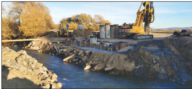
Szentivánlaborfalvi híd építése
