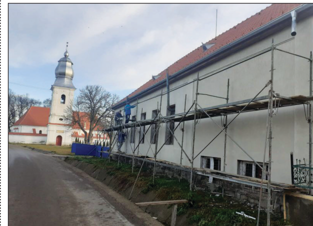
Lisznyói kultúrotthon a felújítás alatt
