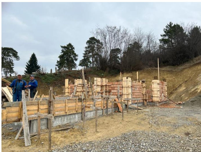
Construcția casei mortuare în Lisnău
