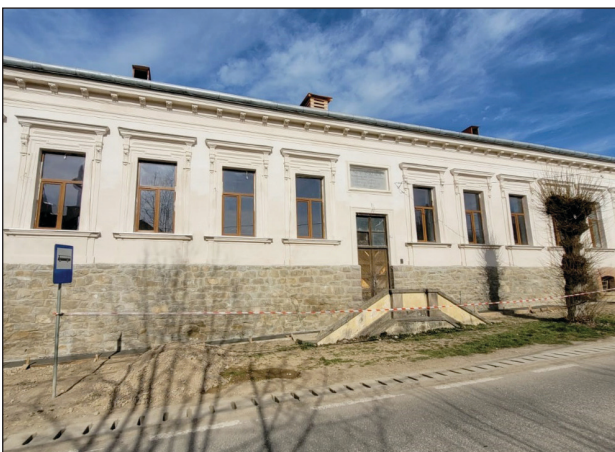
Bikfalvi iskola felújítása
