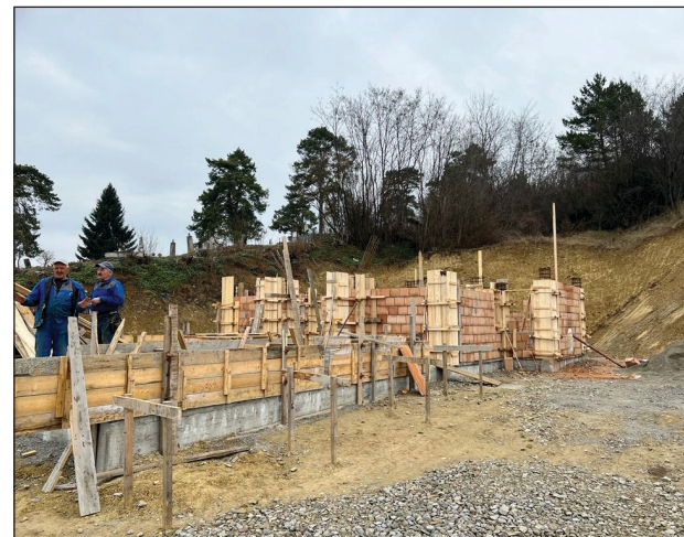
Lisznyói halottasház építése
