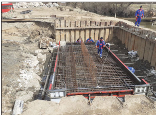
Szentivánlaborfalvi híd építése
