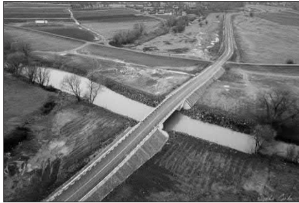
Új betonhíd a Feketeügy folyó felett
