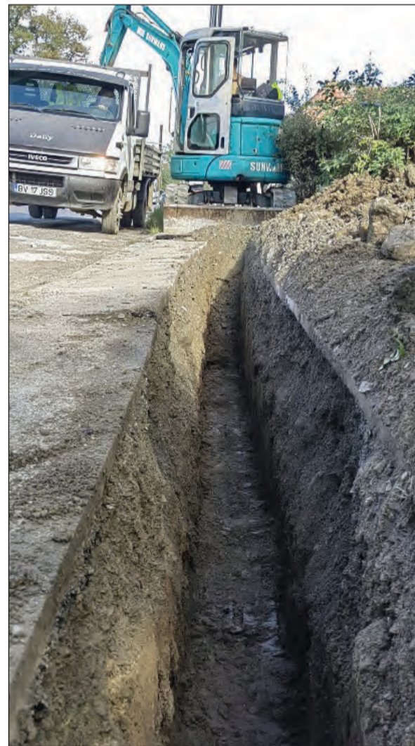
Gázvezeték elhelyezése Uzonban
